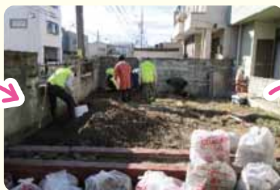
草・木 撤去完了
